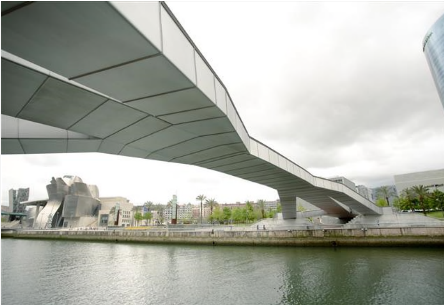
Figuur_10 - Duplex is in opkomst als constructiemateriaal voor bruggen
