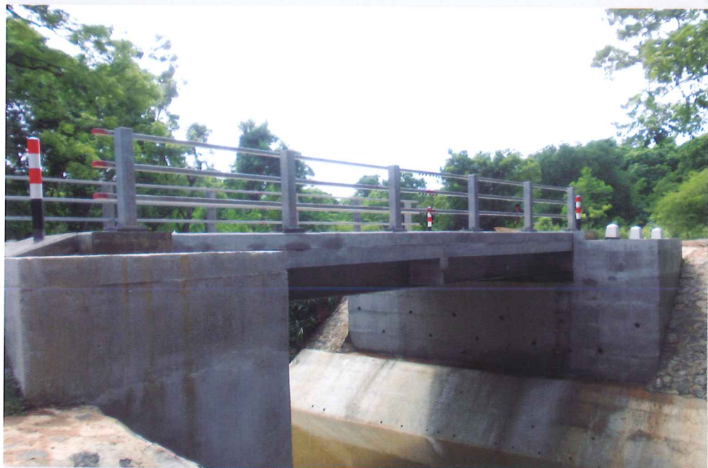
Enkele voorbeelden van de 463 bruggen die worden geleverd en geïnstalleerd door de Nederlandse exporteur Janson Bridging in de komende 3 jaar in Sri Lanka.
