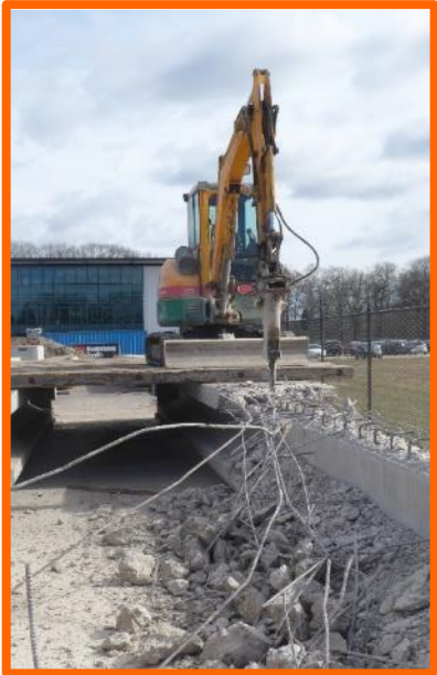
Verwijderen van druklaag
