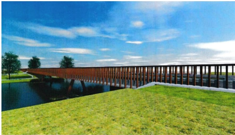
Floriade tweede leven brug Onderdelen van de A27 loopbrug Liggers van brug in Zoetermeer
